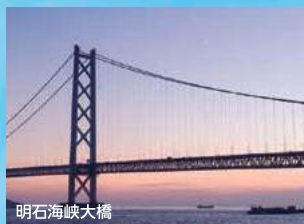
明石海峡大橋
